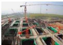
南京长江四桥各关键基础项目建设进展顺利
